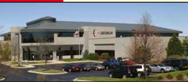
Наш центральный офис в Ваукегане (Иллинойс, США)
